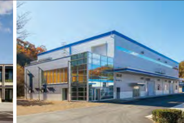
鍋屋バイテック会社様関工園倉庫 建築工事
