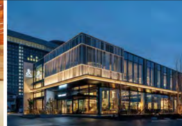
技研サービス様 建築工事
