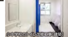
小中学校のトイレ改修工事[建築]
